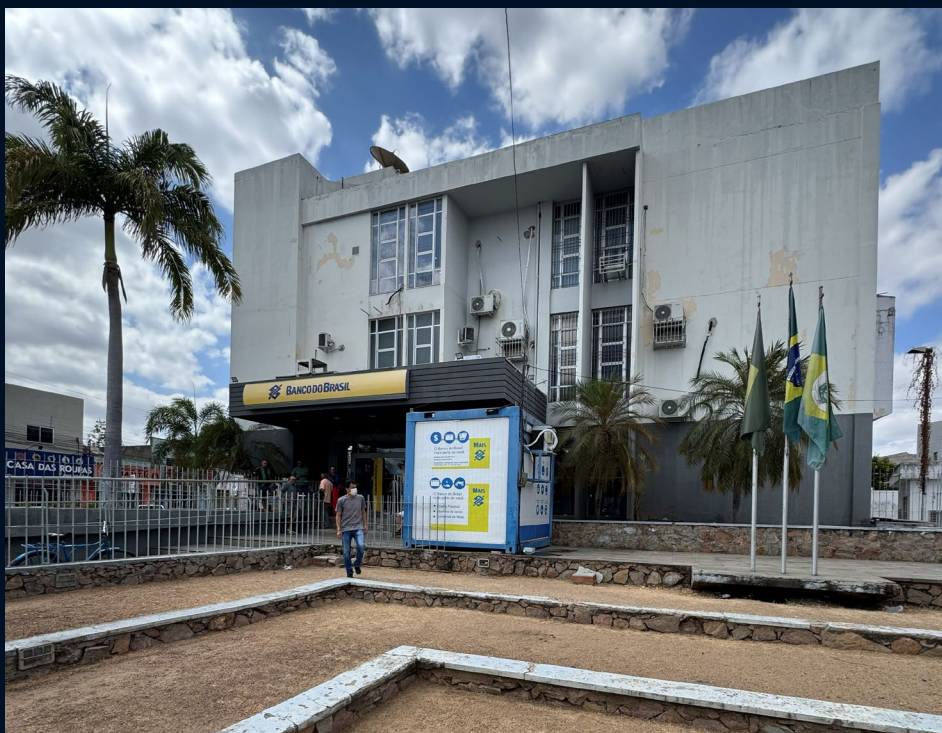
Ag. Crateús — Crateús/CE Reforma Geral da agência
