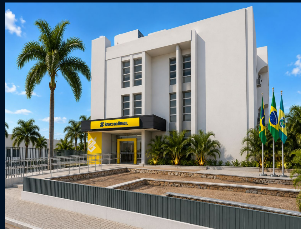
Ag. Crateús — Crateús/CE Reforma Geral da agência
