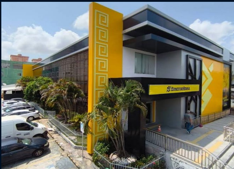
Ag. Bairro da Pedreira — Belém/PA Reforma Geral da agência para COP 30
